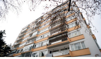
Fotoğraf: Sevgi KÖYLÜ HALİLOĞLU - Ilbank Apartmanları
